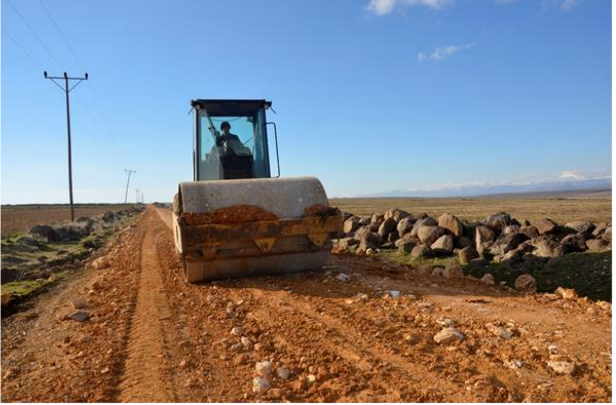
Karaalı Mahallesi Kalker Yol Çalışması
