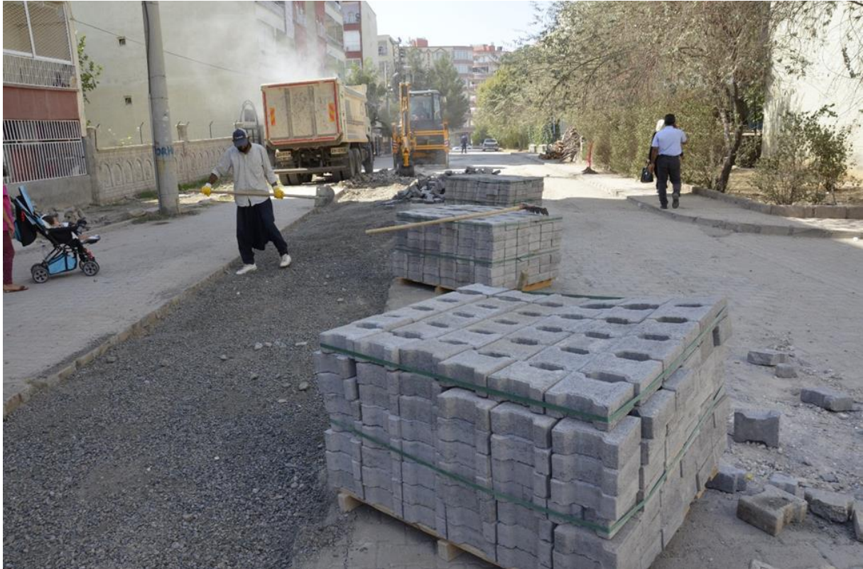
Kilit Taşı Onarımı
