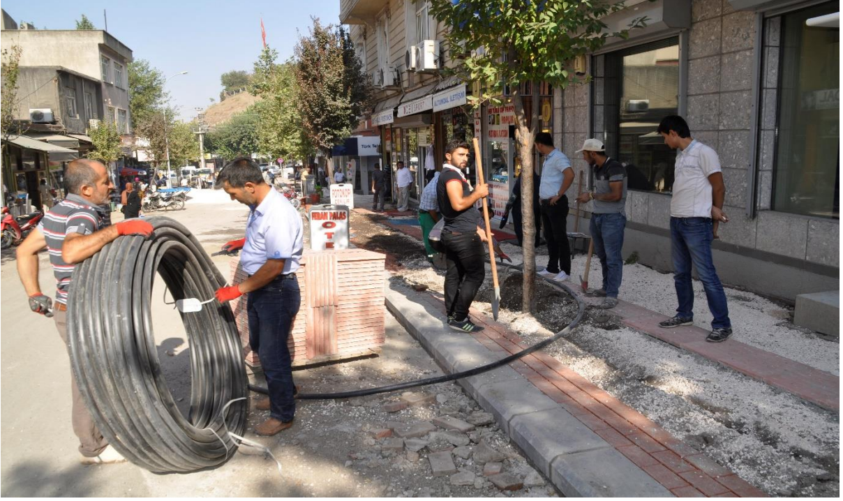
Caddelerde Damlama Sistemi Borularının Döşenmesi
