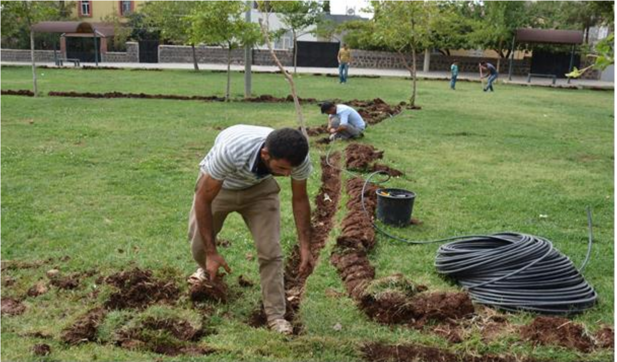
Parklara Damlama Sistemi Borularının Döşenmesi
