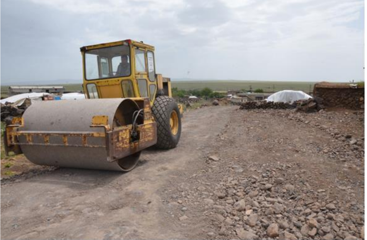
Anacık Kırsal Mahallesi Stabilize Yol Çalışması
