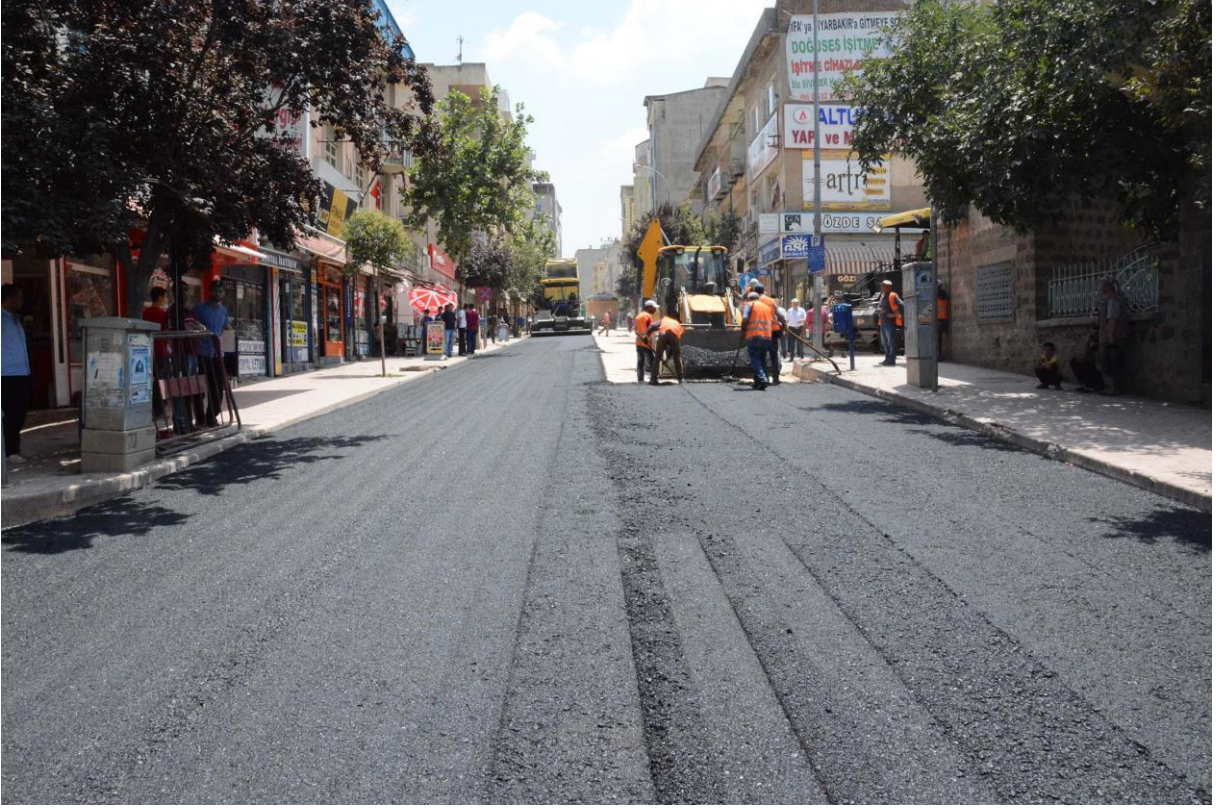
Hürriyet Caddesi Asfalt Serim Çalışması
