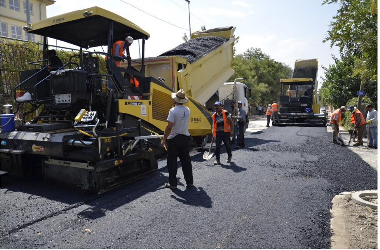
Güney Mahallesi Asfalt Serim Çalışmaları
