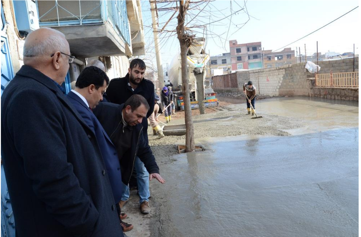
Beton Dökülmesi Çalışması
