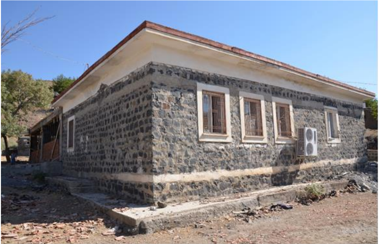
Beydeş Hizmet Evi Yapım Faaliyeti-1
