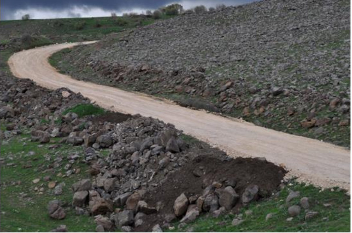
Mezra Kırsal Mahallesi Stabilize Yol Yapılması
