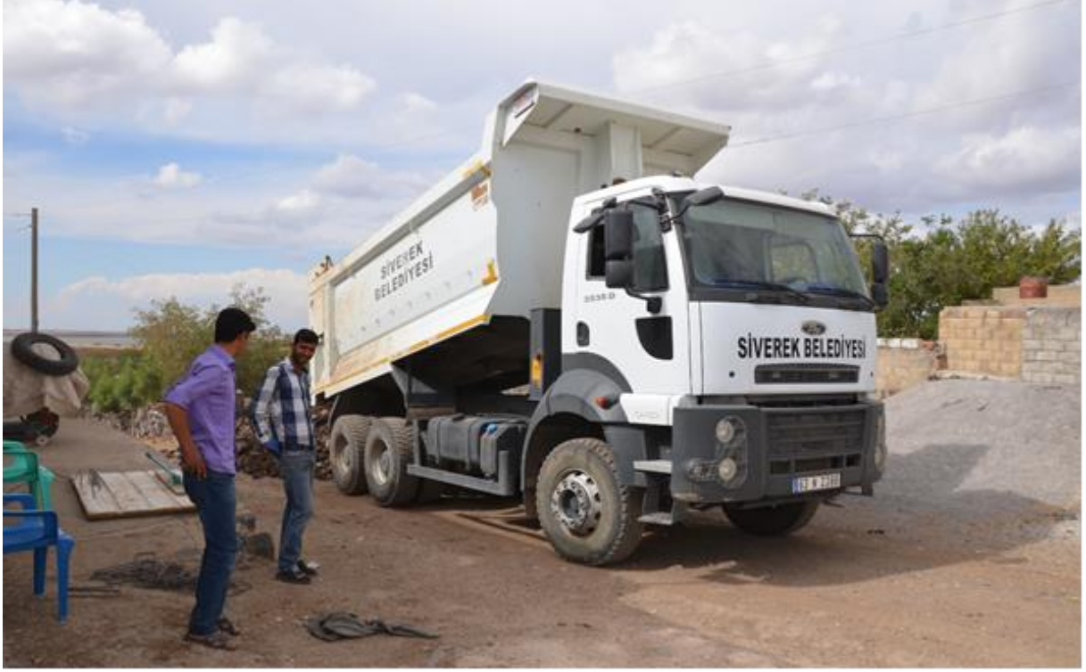
Örgülü Kırsal Mahallesi Stabilize Yol Yapılması
