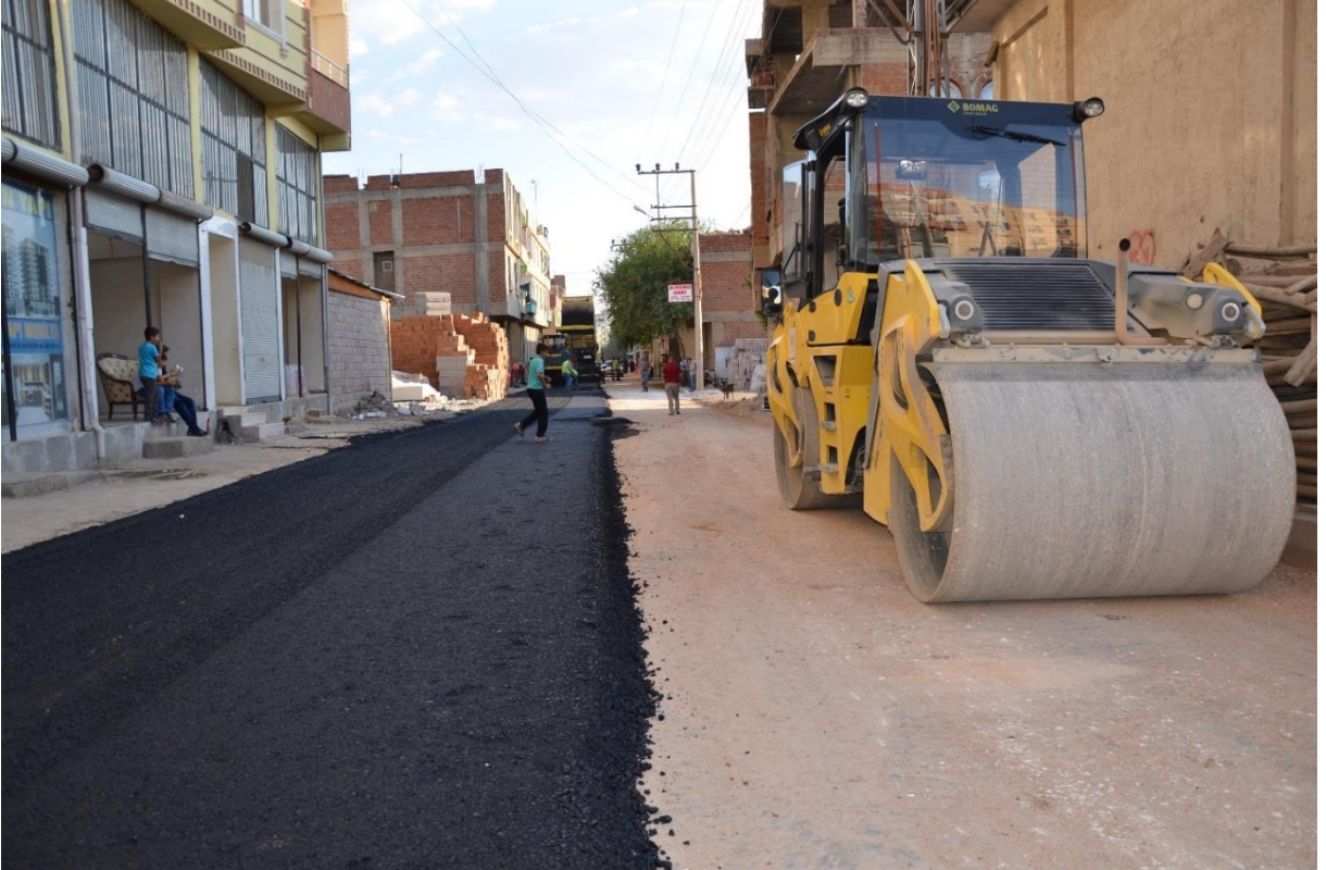
Hacıömer Mahallesi- Şeyh Samil Caddesi Asfalt Serim Çalışmaları
