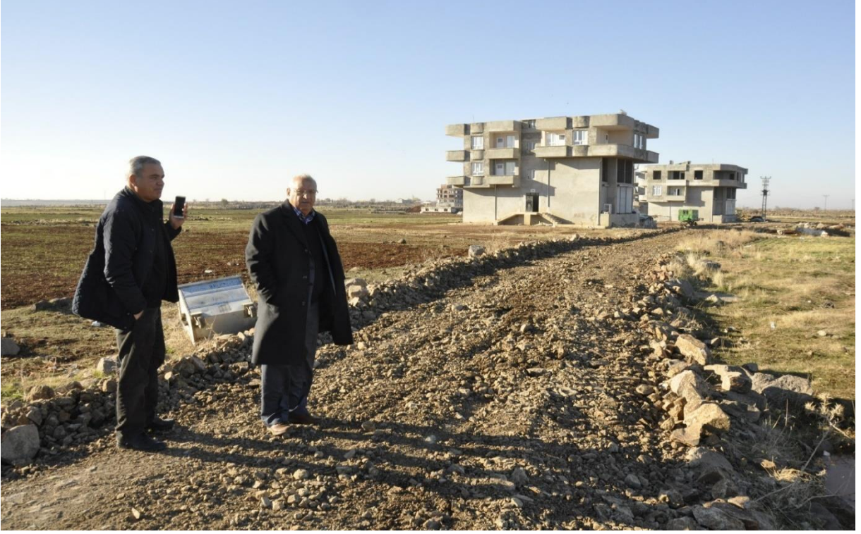
Stabilize Yol Yapımı
