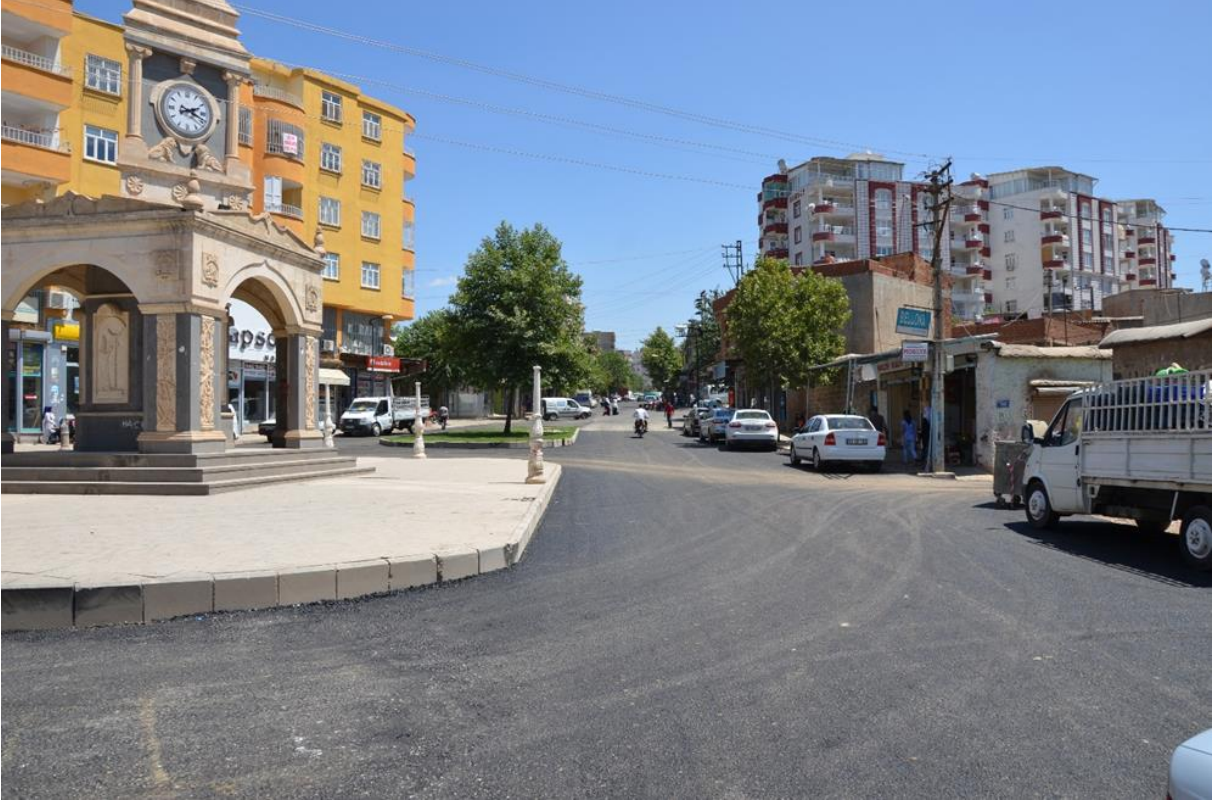
Esmerçayır Mahallesi Asfalt Serim Çalışmaları
