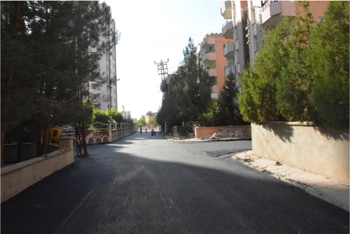
Bahçelievler Mahallesi Asfalt Serim Çalışması
