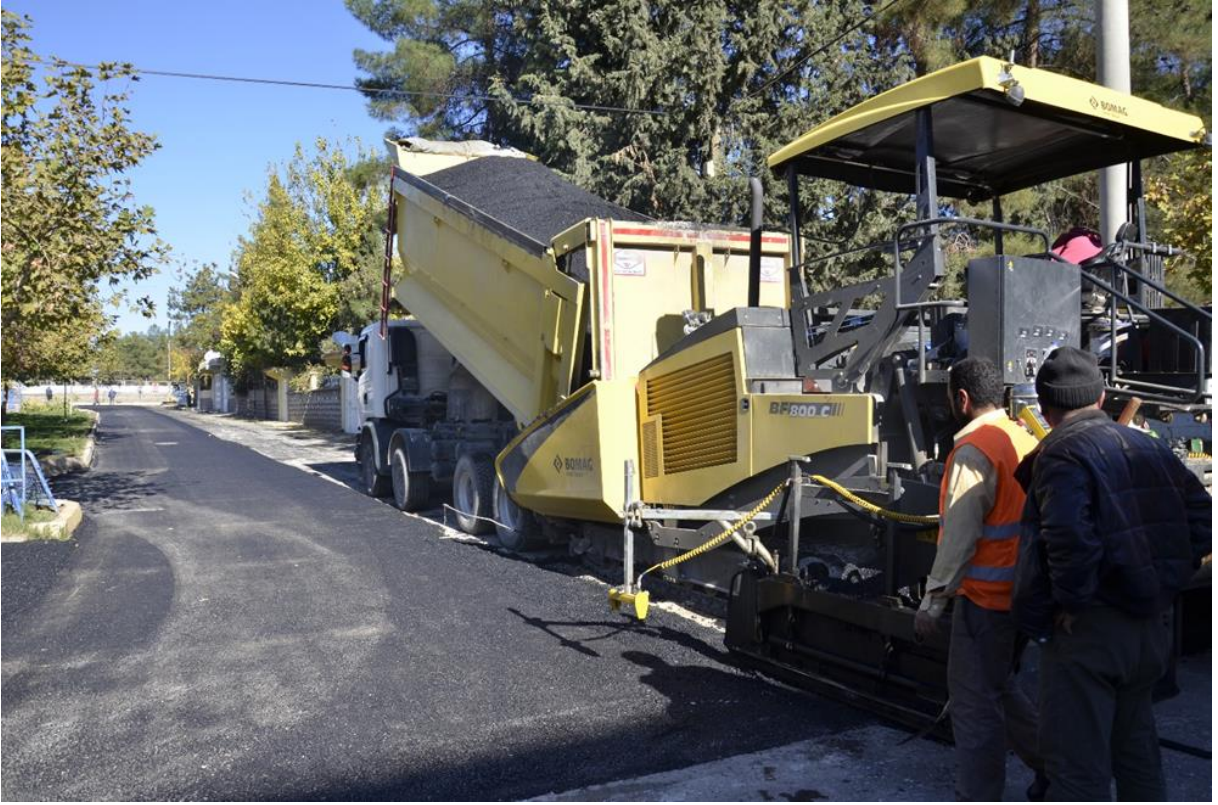
Ofis Mahallesi Asfalt Serim Çalışmaları
