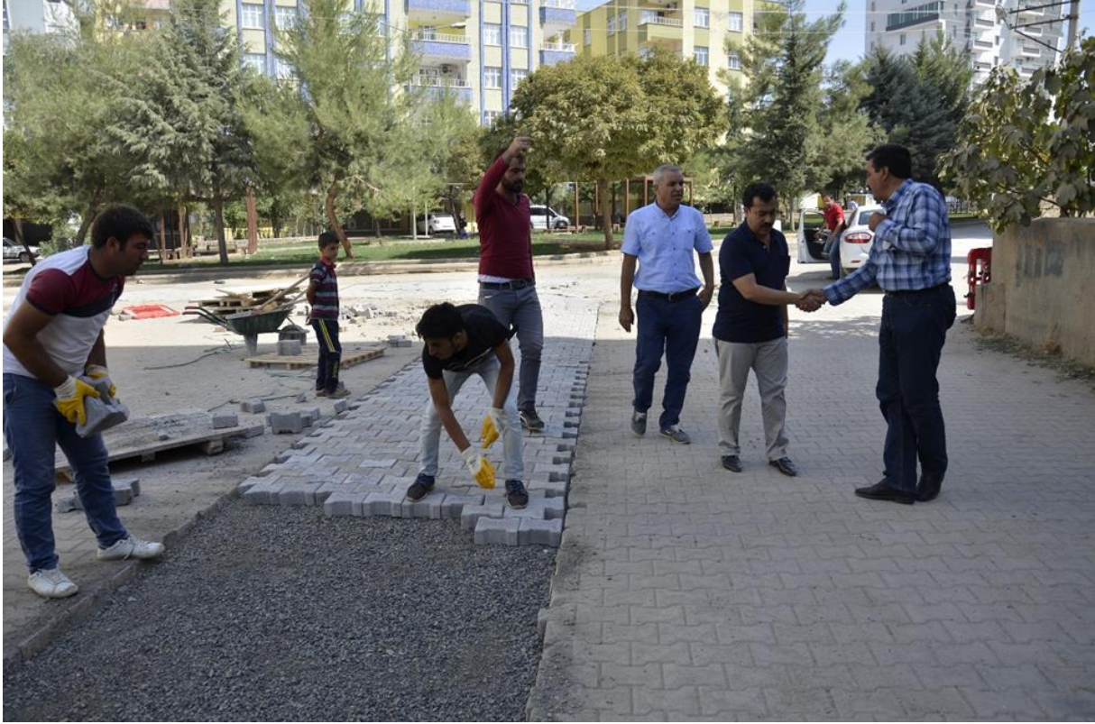
Kilit Taşı Onarımı
