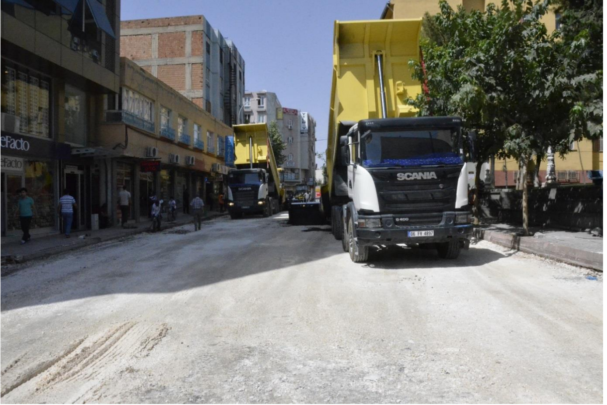
Rüstü Küçükömer Caddesi Asfalt Serim Çalışması
