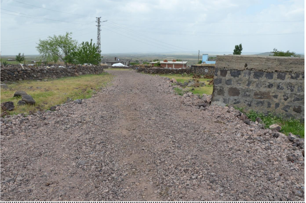
Gazi Kırsal Mahallesi Stabilize Yol Çalışması-2
