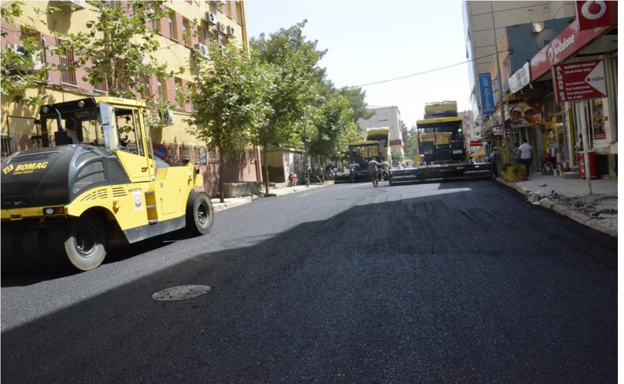
Rüstü Küçükömer Caddesi Asfalt Serim Çalışması
