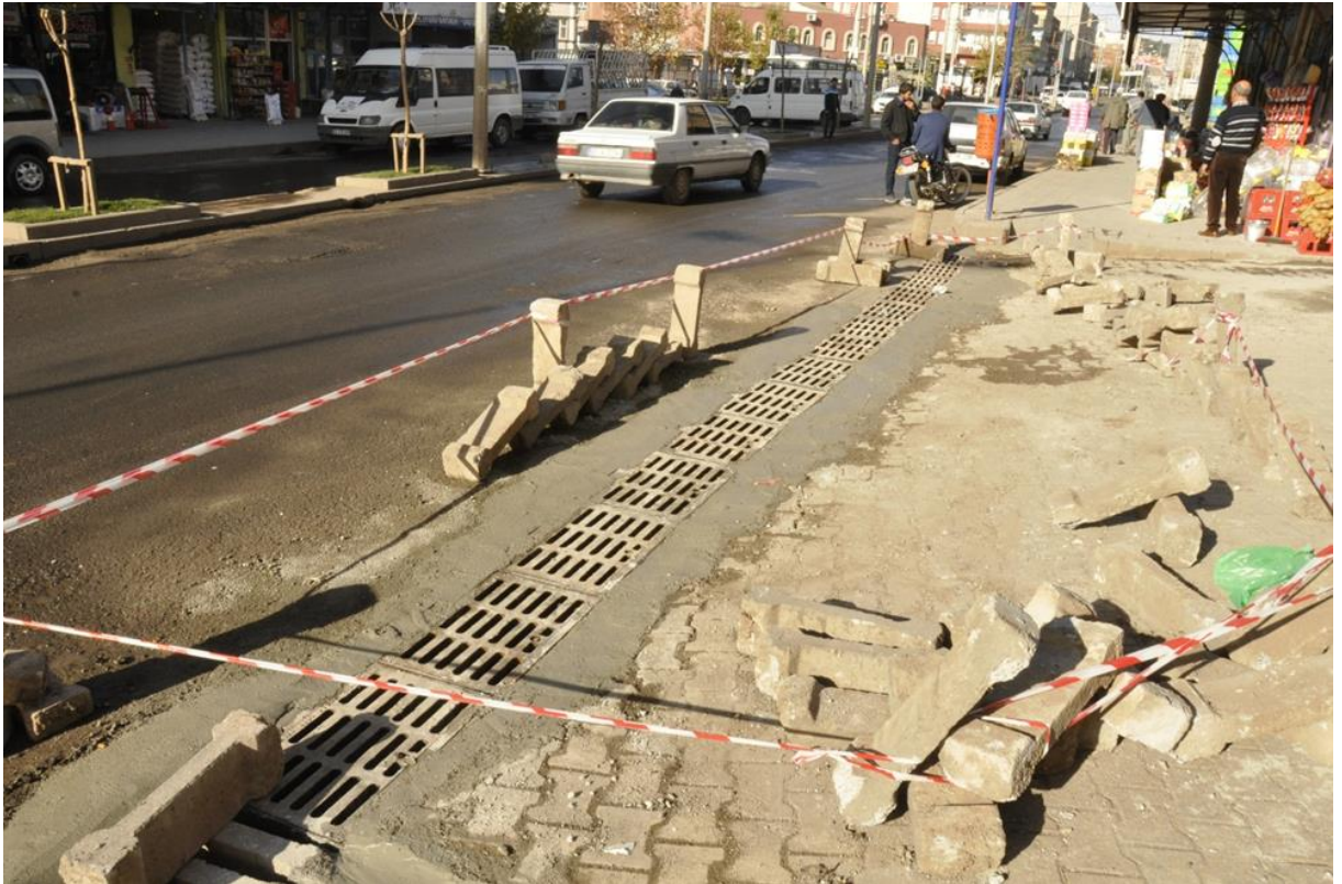
Yağmur Izgara Çalışmaları
