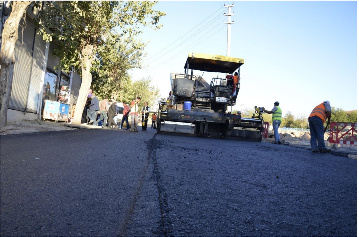
Hacıömer Mahallesi Asfalt Serim Çalışması
