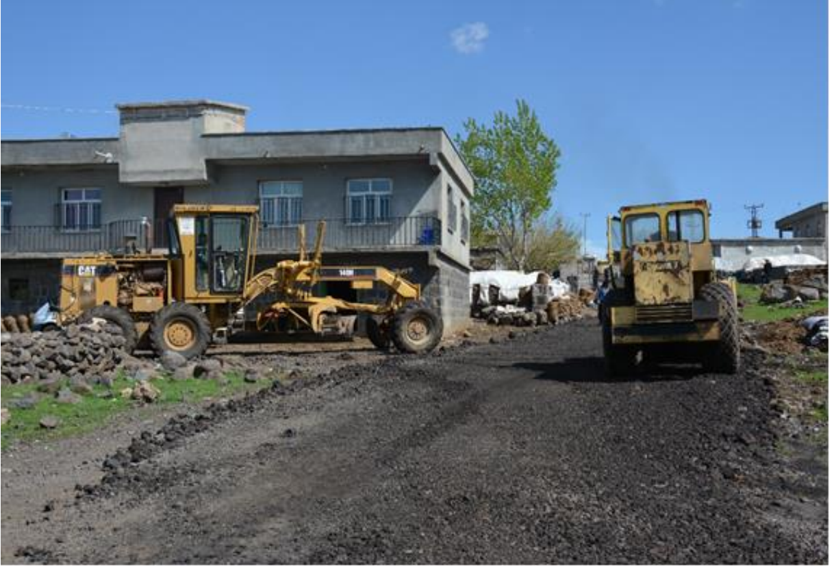
Gazi Kırsal Mahallesi Stabilize Yol Çalışması-1
