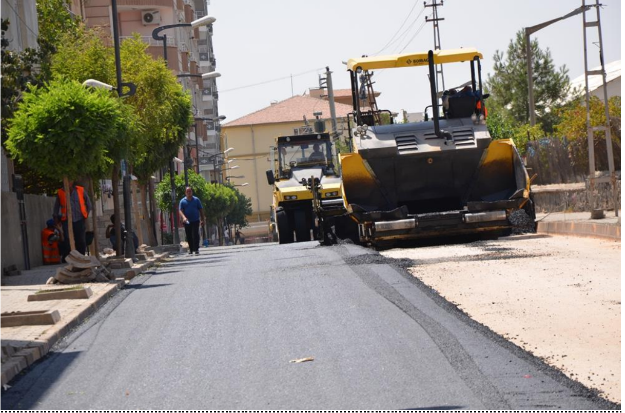
Kızılaöl Caddesi Asfalt Serim Çalışması
