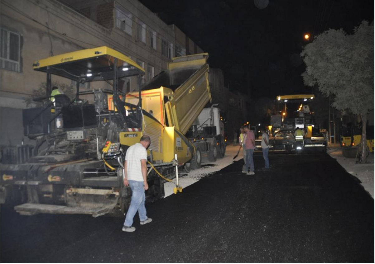
Abdalaga Mahallesi Asfalt Serim Çalışması
