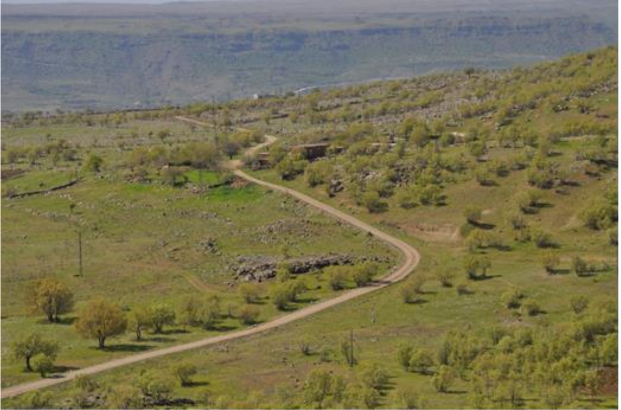
Kellehan(Engin) Kırsal Mahallesi Stabilize Yol Çalışması
