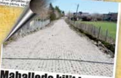
Mahallede kilit taşı çalışması tamamlandı
