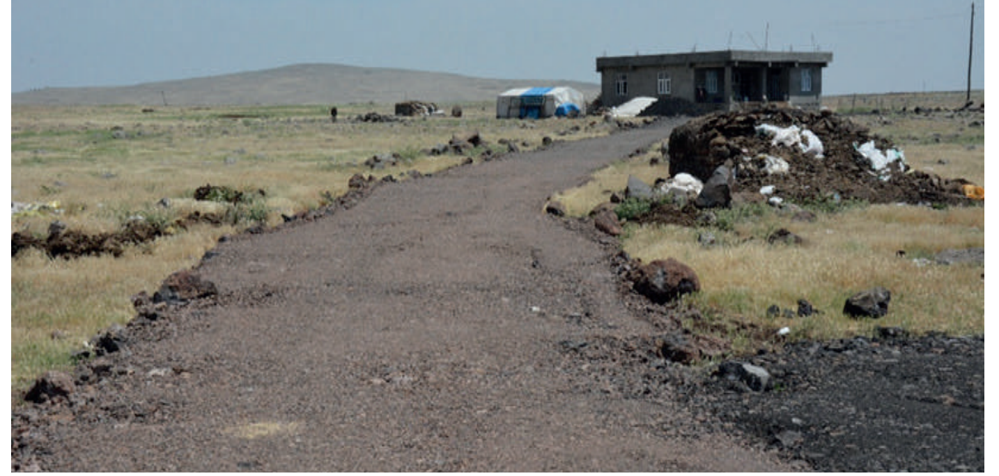
Ekinci Stabilize Yol Yapılması
