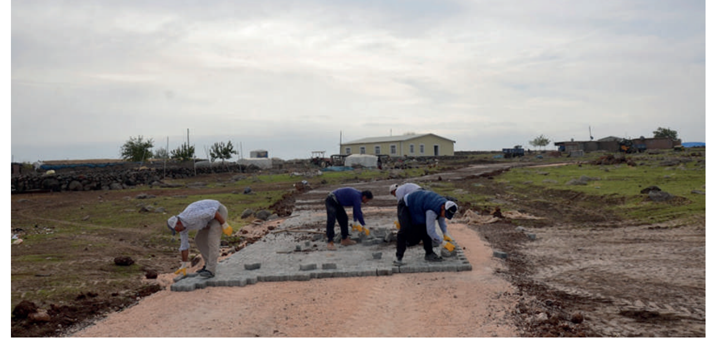
Kaynakbaşı Parke Taşı Yapılması
