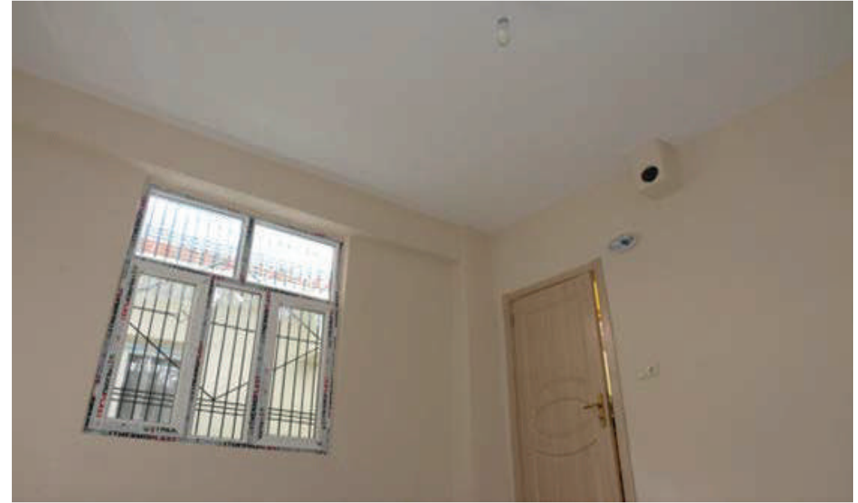
Yardıma Muhtaç Aileler İçin Yapım Onarım Faaliyeti-2
