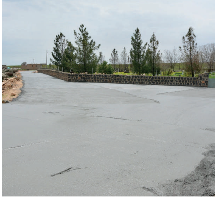
Kazanlı Beton Yol Çalışması
