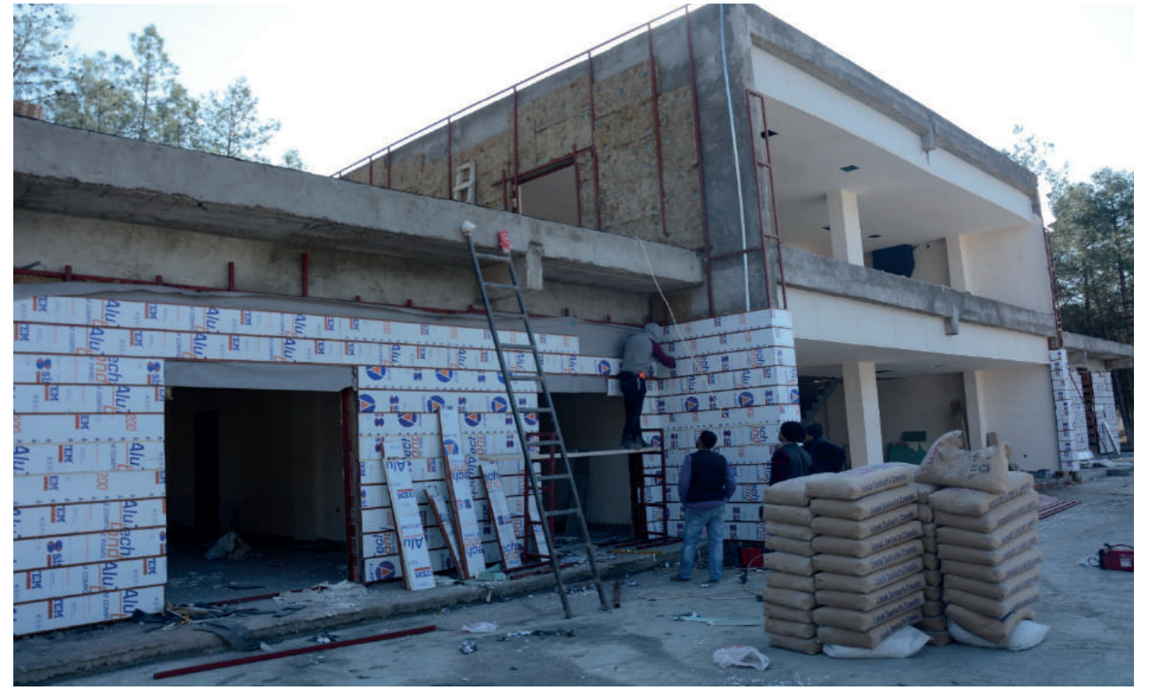
Olimpik Yüzme Havuzu Yapımı Devam Ediyor-2
