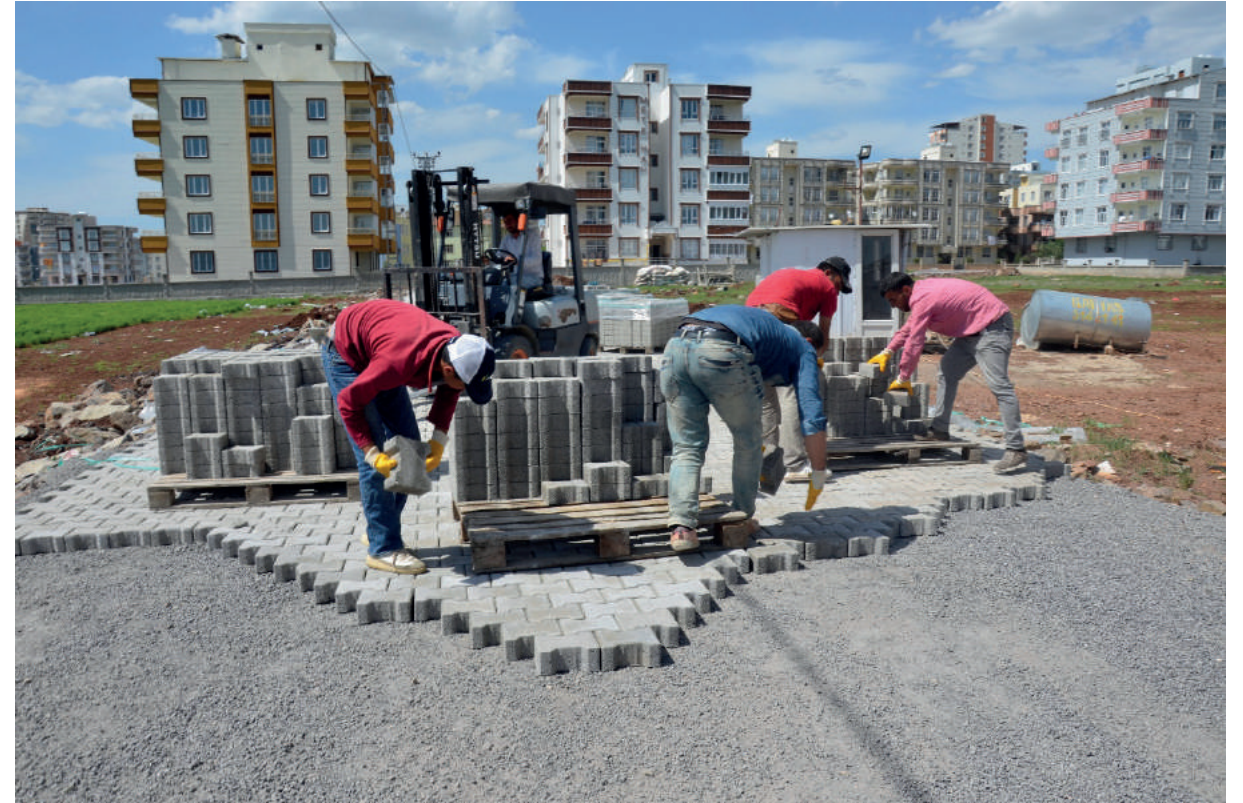
Parke Yol Yapımı-1
