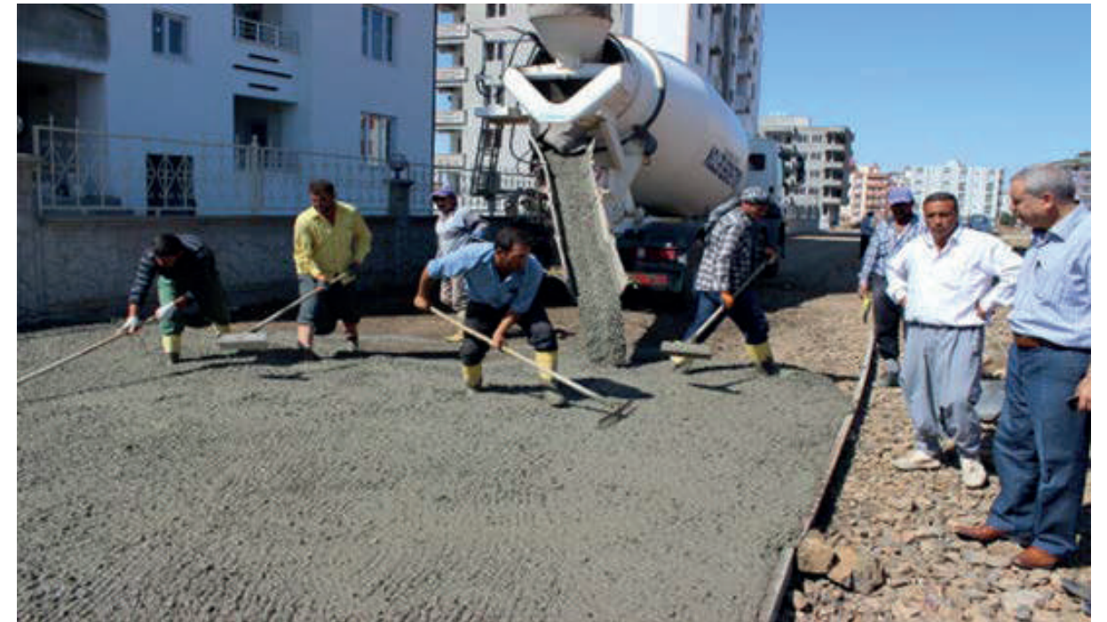
Beton Yol Yapımı-1
