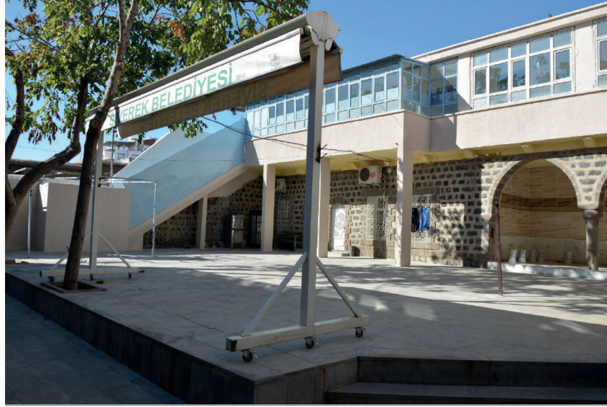
Cami Bakım Onarım-3
