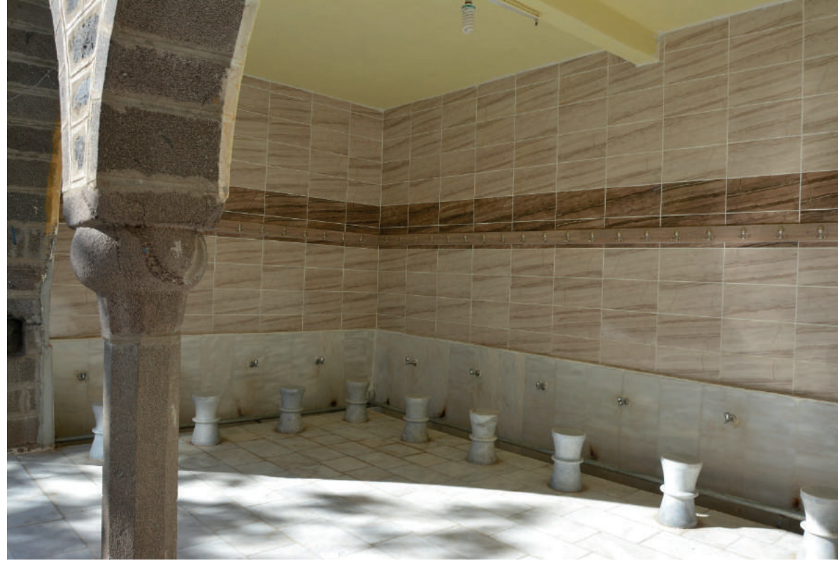
Cami Bakım Onarım-2
