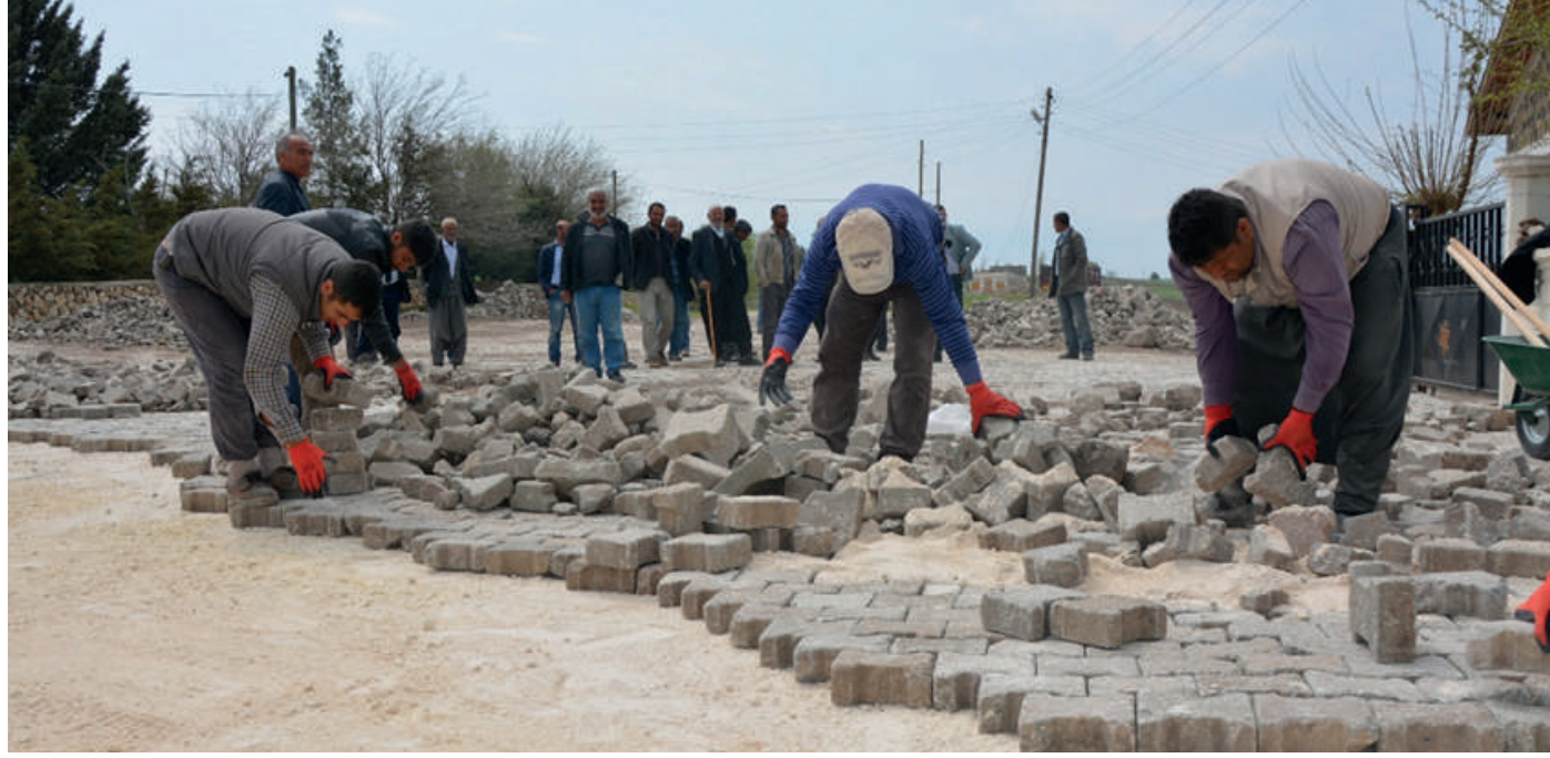
Çaylarbaşı Parke Taşı Yapılması
