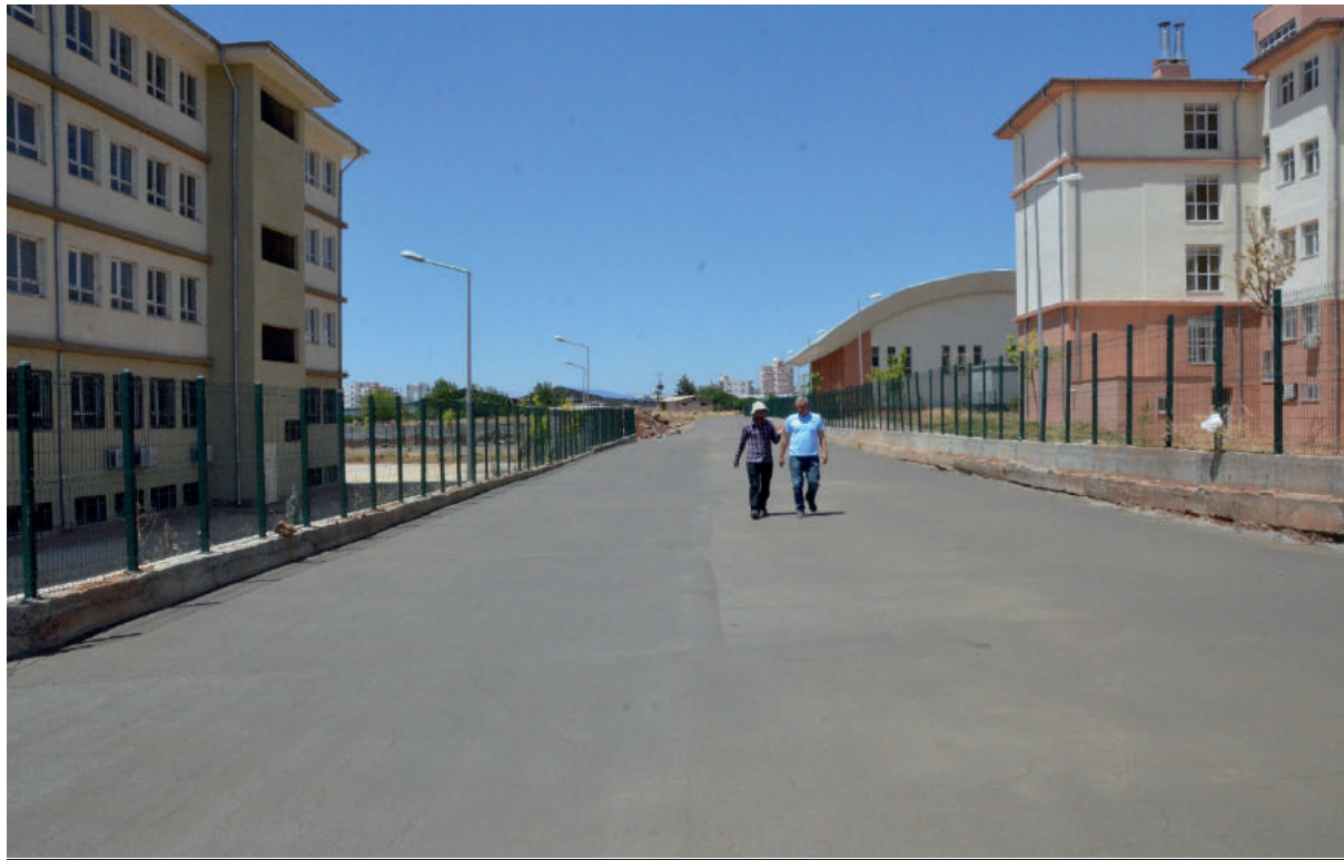
Beton Yol Yapımı-3
