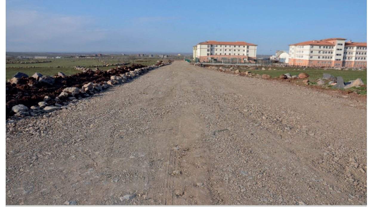
Stabilize Yol Yapımı-2
