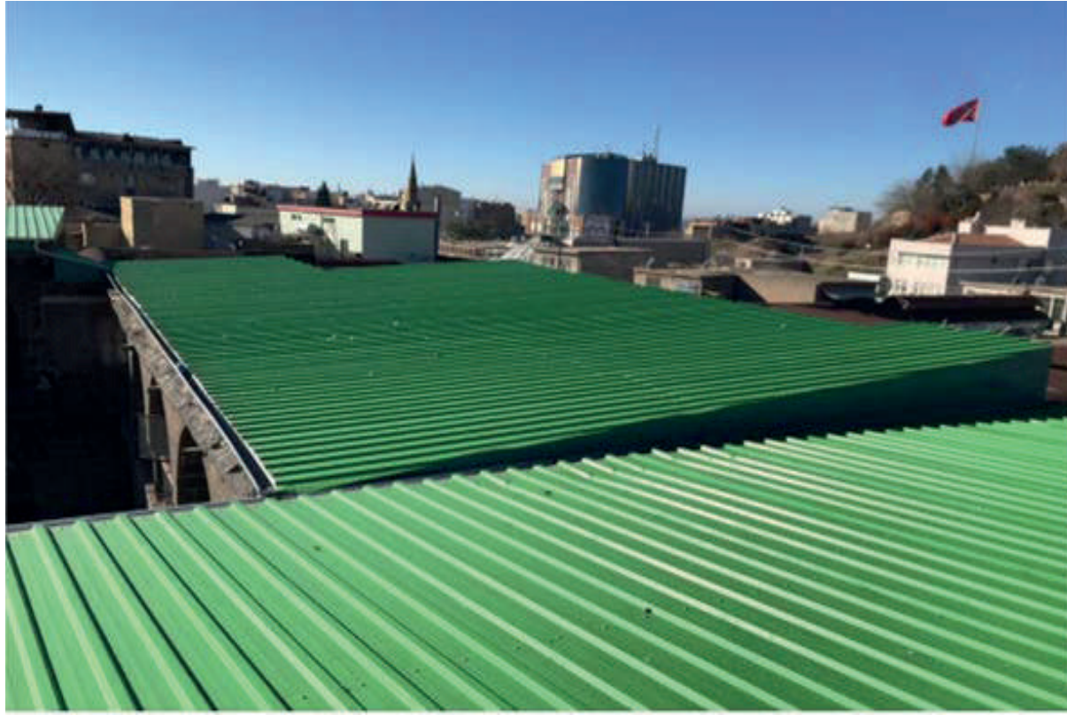
Çatı Yapım İşİ
