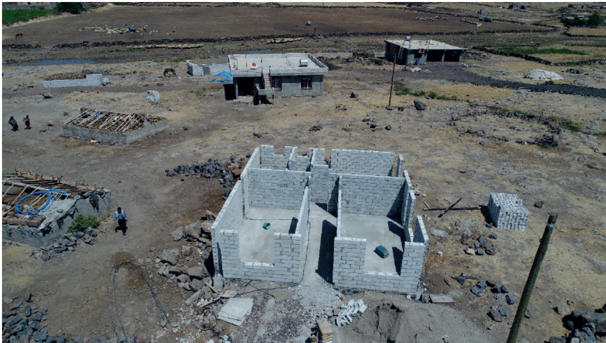
Yardıma Muhtaç Aileler İçin Yapım Onarım Faaliyeti-1
