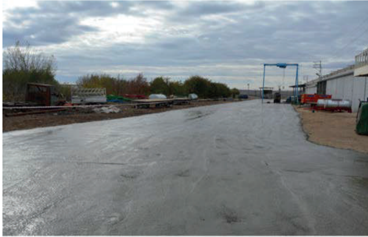
Beton Yol Yapımı-2
