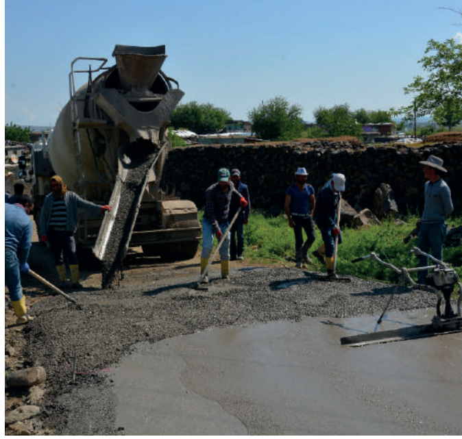
Ertem Beton Yol Çalışması
