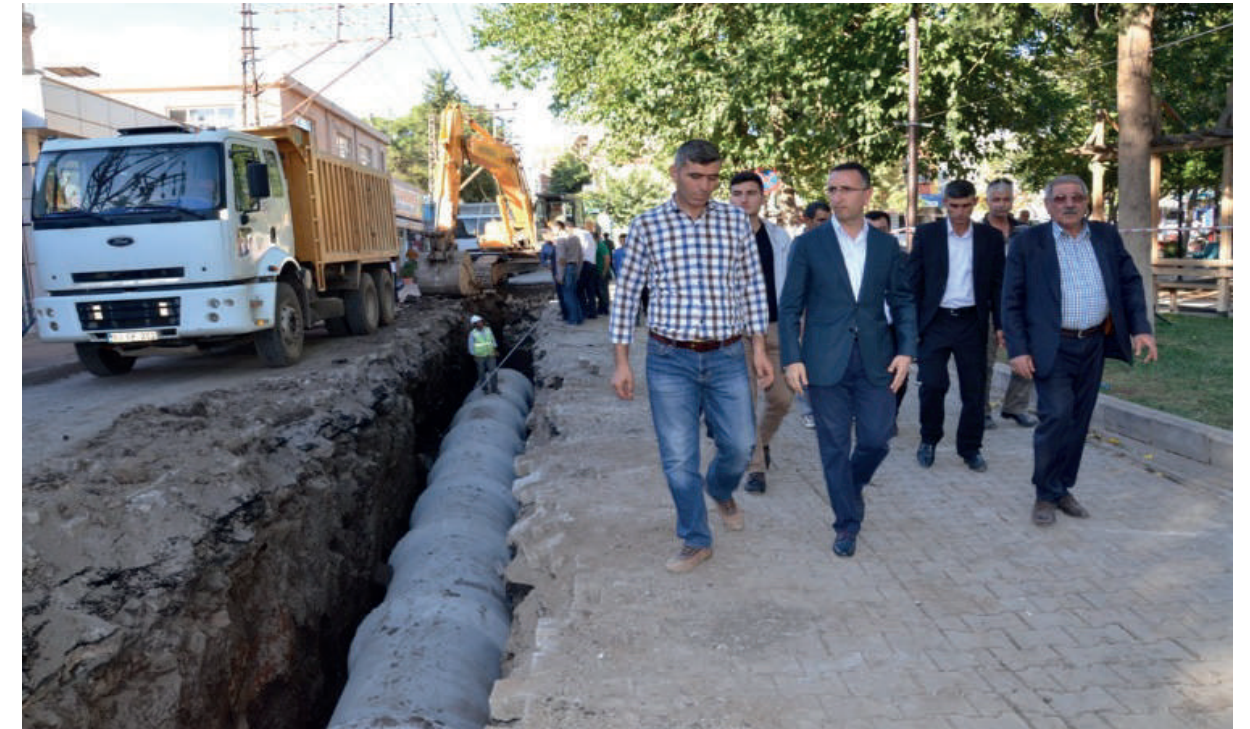
Kanalizasyon Alt Yapı Çalışmaları
