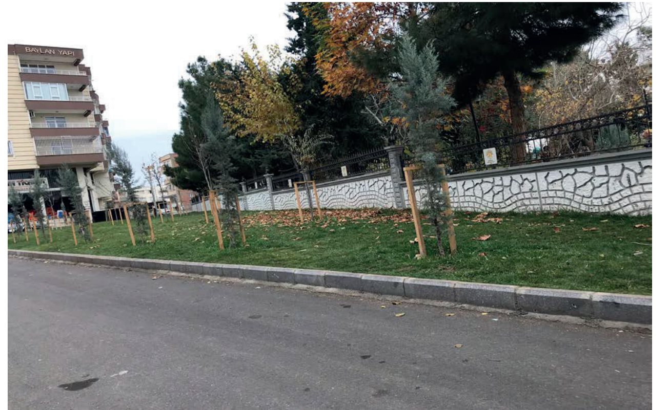
Dicle Mahallesi Yeşil Alan Yapımı
