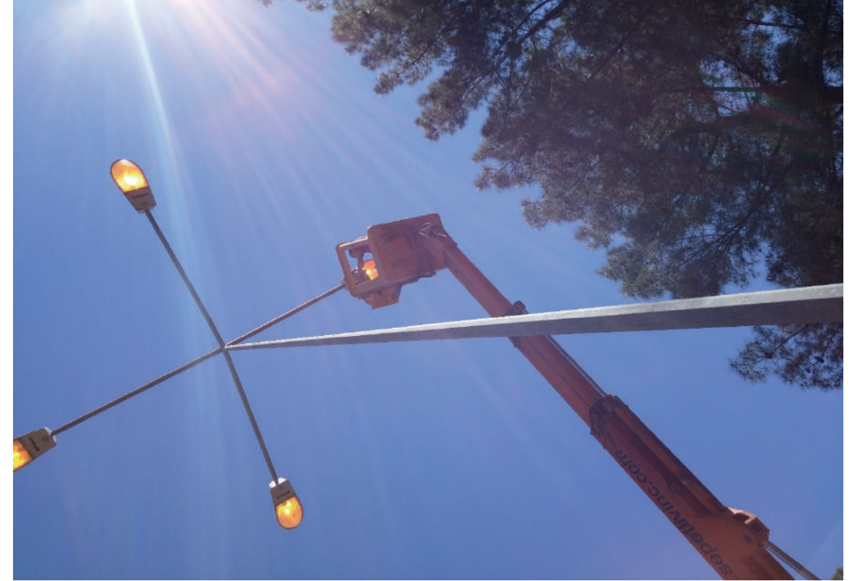
Elektrik Bakım Onarım Çalışması Faaliyeti
