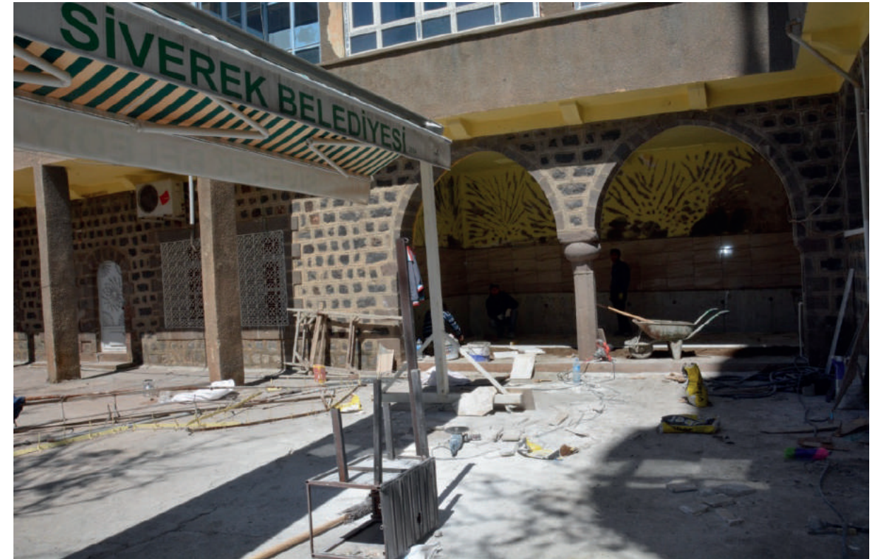
Cami Bakım Onarım-1
