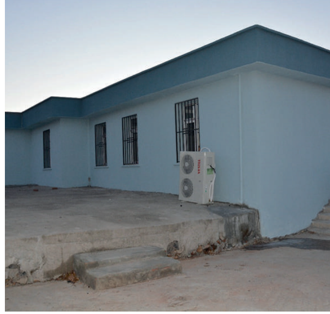
Karabahçe Taziye Evi
