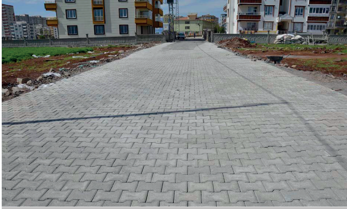
Parke Yol Yapımı-3
