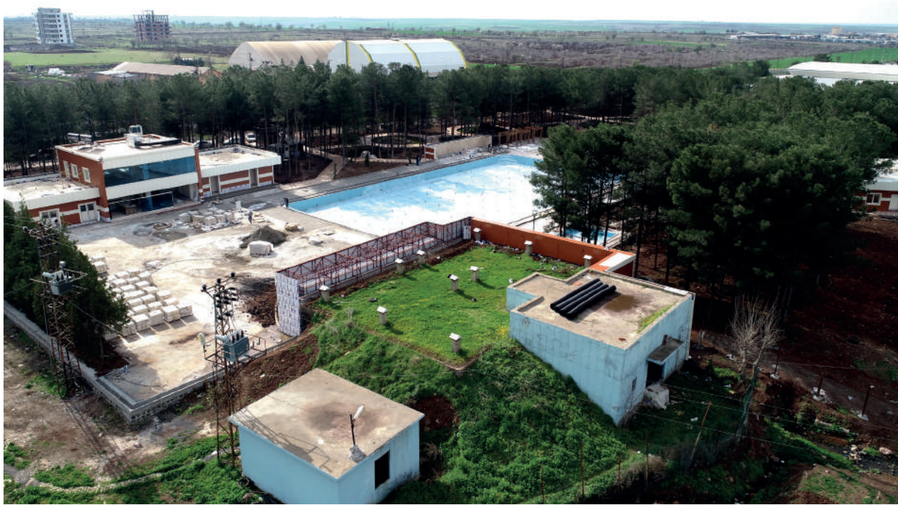
Olimpik Yüzme Havuzu Yapımı Devam Ediyor-1
