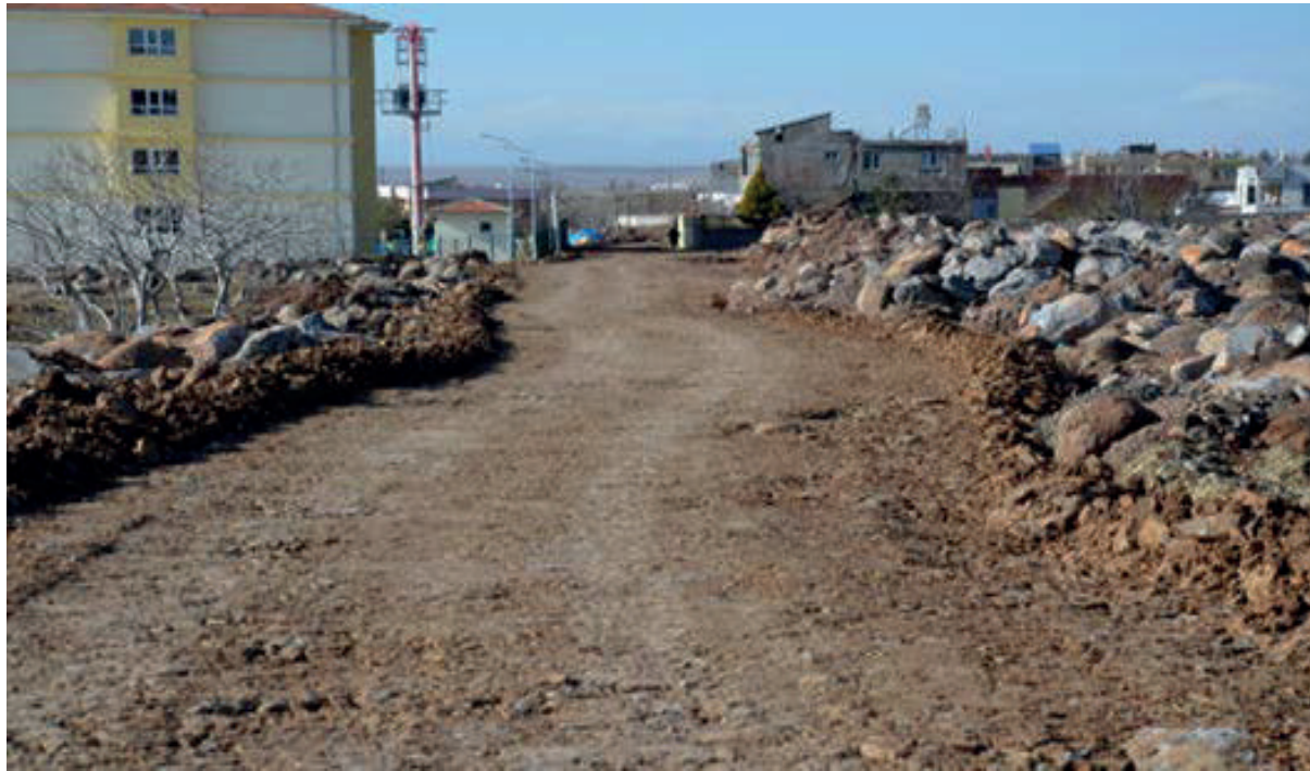
Stabilize Yol Yapımı-1
