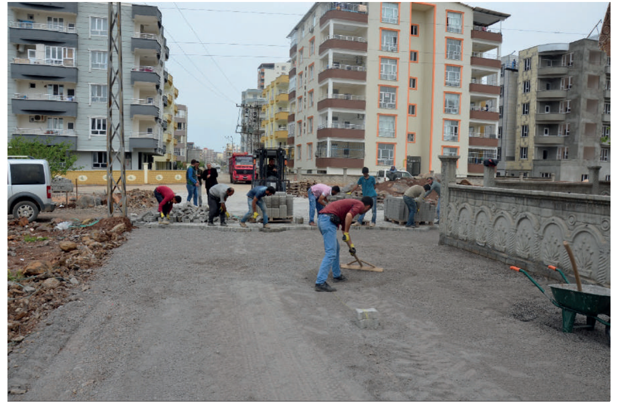
Parke Yol Yapımı-2
