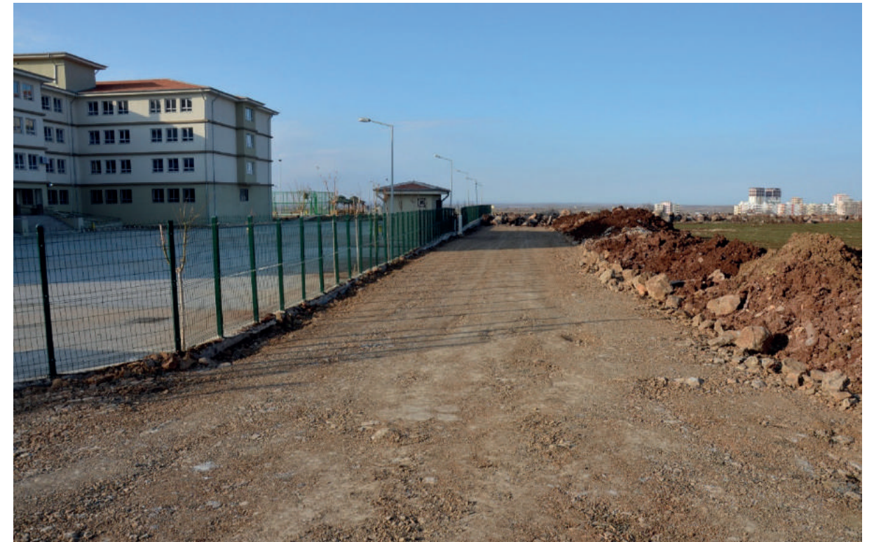
Stabilize Yol Yapımı-3
