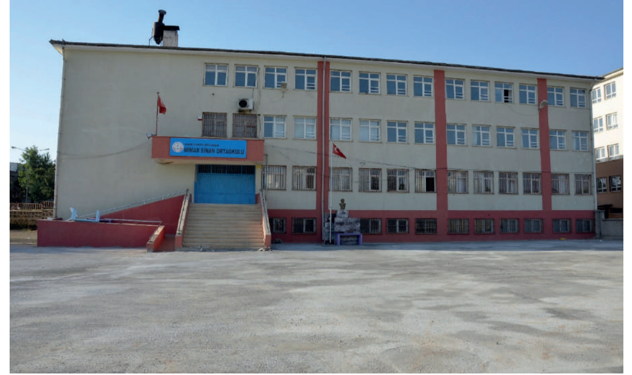
Okullara Saha Betonu Çalışması
