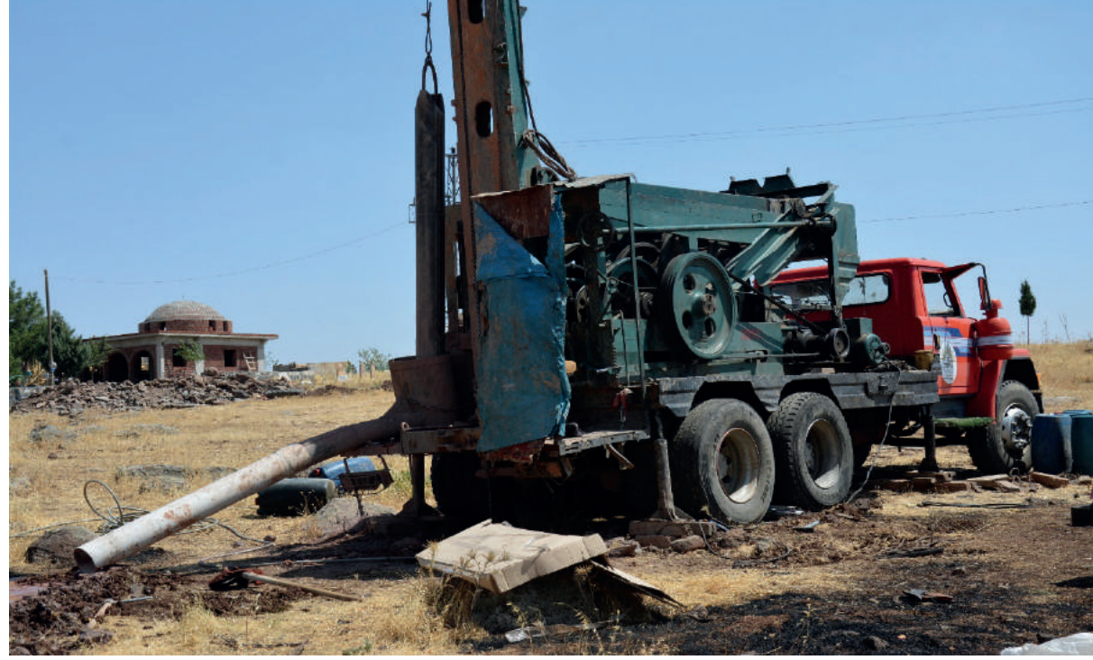
Sondaj Kuyusu Açılması
