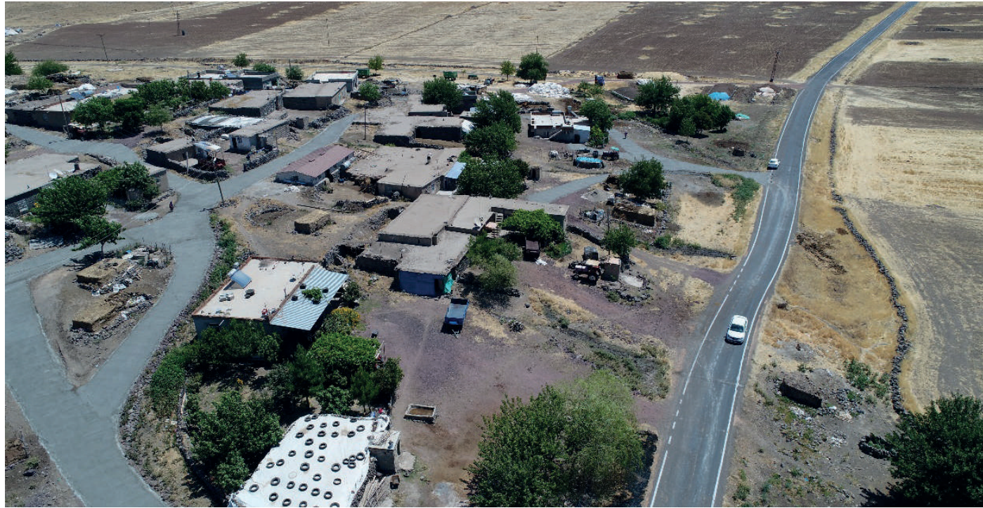
Cinhisar Beton Yol Çalışması
