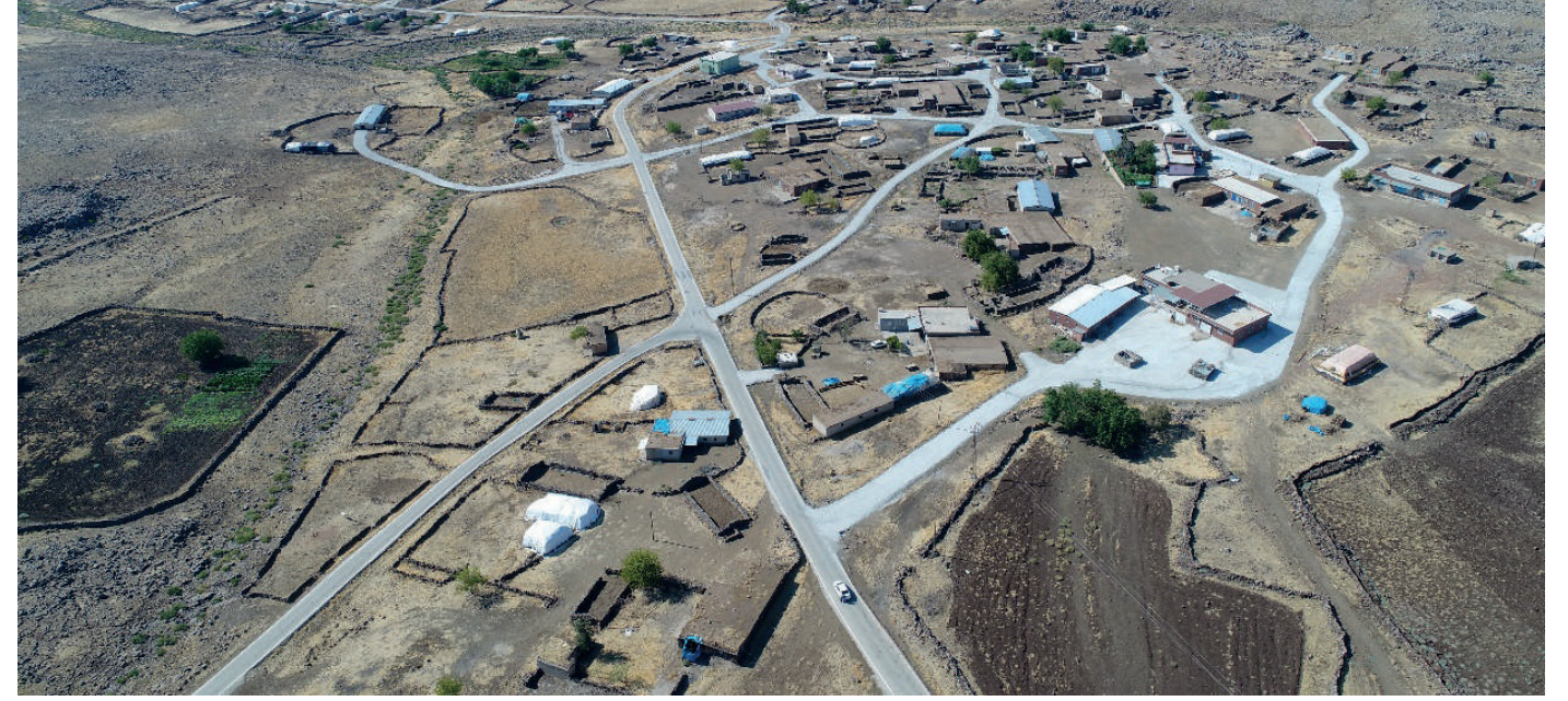
Hamamören Beton Yol Çalışması
