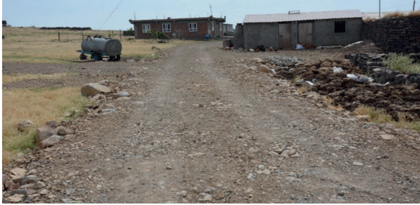
Karlık Stabilize Yol Yapılması
