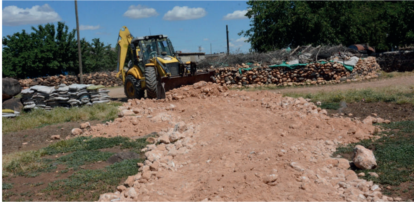
Sarıören Stabilize Yol Yapılması
