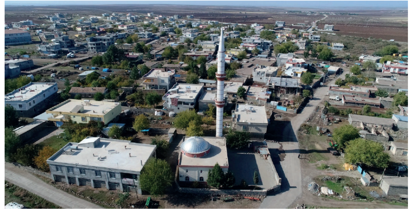
Beton Yol Çalışması
